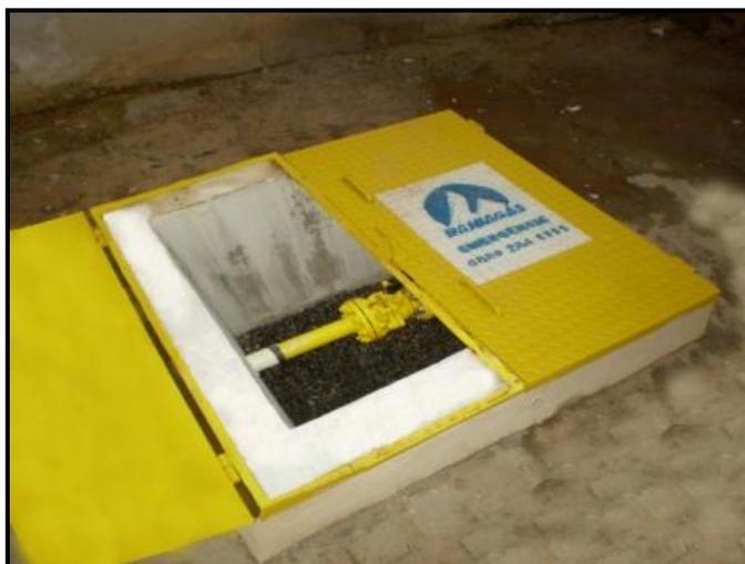
**Figura 9:** Caixa de válvulas em aço pertencente à Bahiagás.
