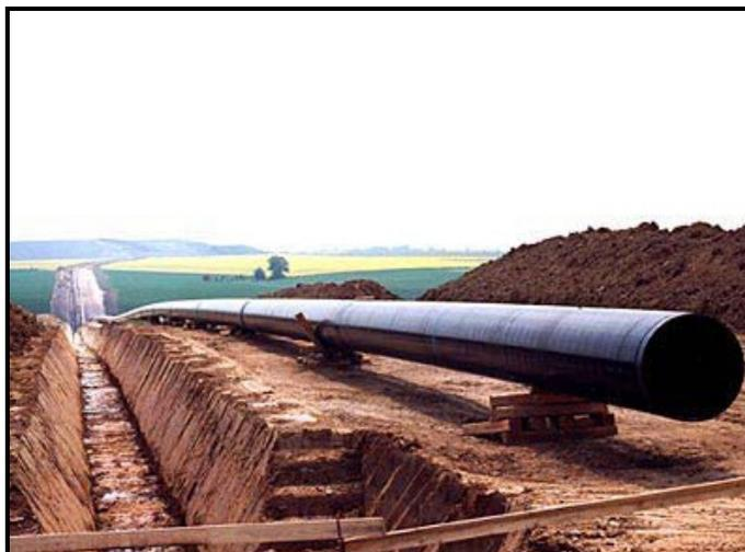
**Figura 6:** Construção de gasoduto pelo método destrutivo ou abertura convencional.
