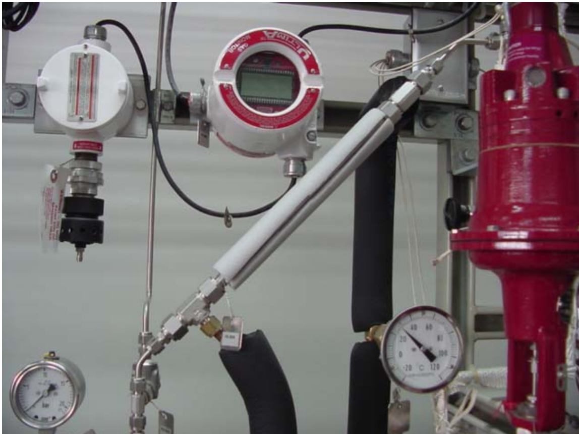
Figura 10 – Condensador/Trocador de calor da unidade de separação
