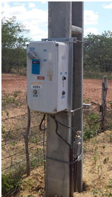
Figura 36 - Painel de controle de fornecimento de corrente elétrica.
