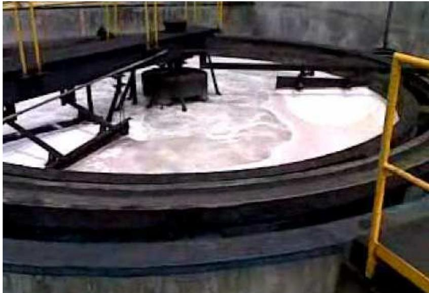
Figura 2.6: Flotador por ar dissolvido.
