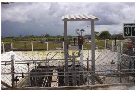
**FIGURA 8 – Tanque de Neutralização do Efluente Orgânico**
